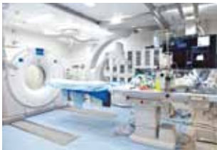
1F 救命救急センター (IVR-CT装置)
