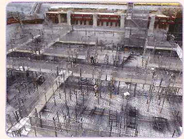
●平成26年11月20日 基礎配筋
