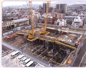
●平成26年12月20日 新本館定点写真
