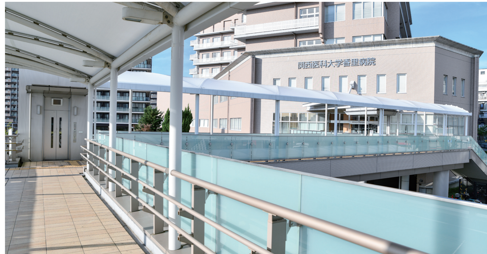
京阪電車香里園駅から病院へ直通の歩行デッキ
